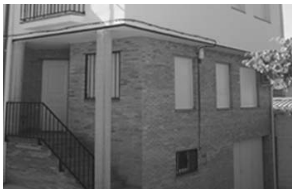
Las obras han supuesto una inversión de 180.000 euros
