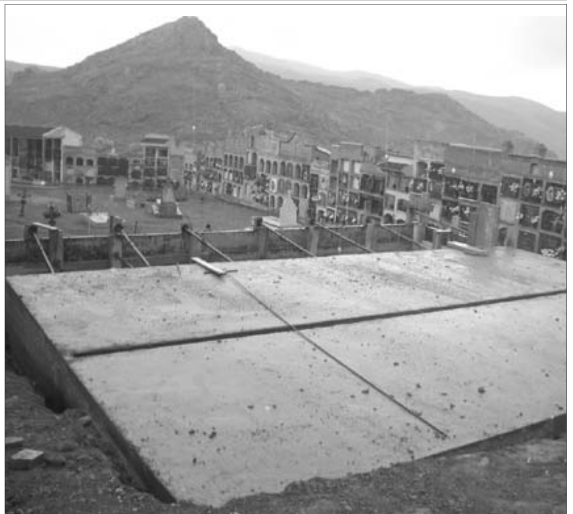
Las obras están previsto que concluyan en los próximos días
