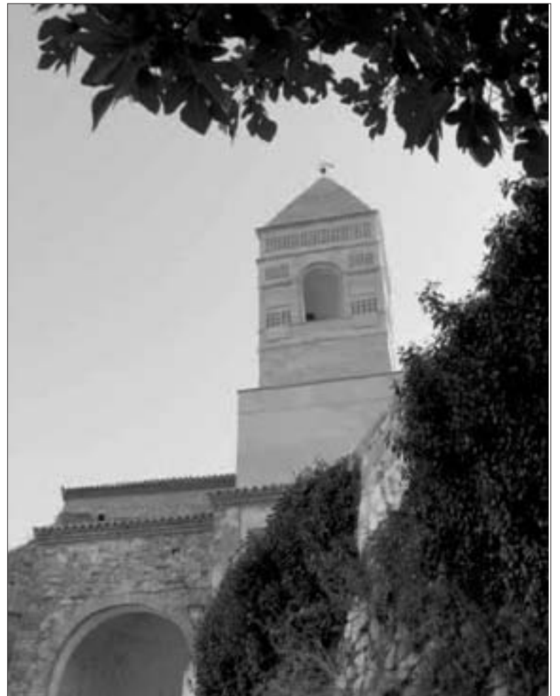
Comienza la Primera Fase de restauración del templo la que el Gobierno de Aragón ha adjudicado la obra es DAMARIN S.L. Esta primera fase de restauración está enmarcada dentro del proyecto inicial de restauración completa del templo que el Gobierno de Aragón confeccionó hace varios años. El coste de la reforma integra está presupuestada en 1.200.000 euros. Pilar López Rojo
