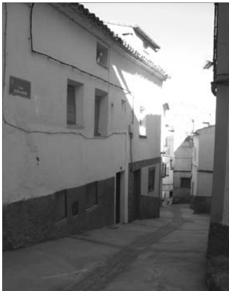
Las obras en la calle Alfajarín ya están finalizadas
