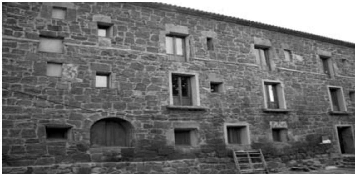
Con la ayuda recibida se han colocado puertas y ventanas nuevas
