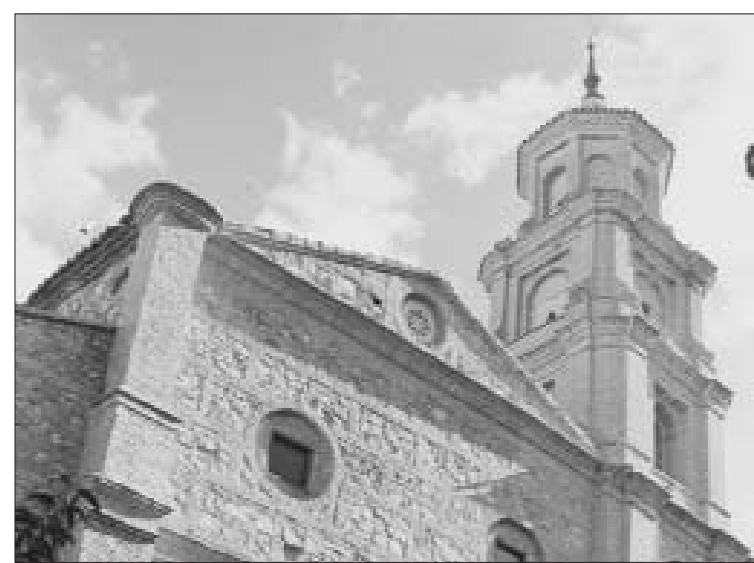
La torre de la iglesia de Jarque recibirá ayuda para su rehabilitación la DPZ también destinará una partida, en este caso de 33.000 euros (el Consistorio de la localidad deberá financiar el resto de lo presupuestado, 22.000 euros), para la rehabilitación de la torre de la iglesia de San Juan Bautista. Estas ayudas se irán recibiendo de forma fraccionada a lo largo del periodo 2008-2010.
