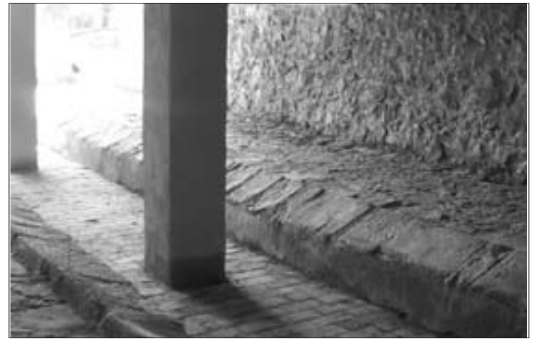
Todavía falta que circule el agua
