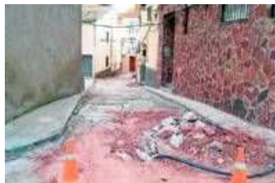
Renovación de redes y pavimentación en Brea.
