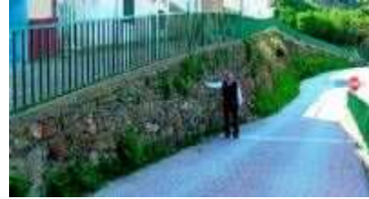
Comienzan en Jarque las obras del fondo estatal.
