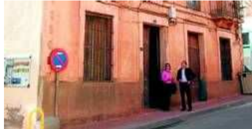
La Diputación de Zaragoza ayudará al ayuntamiento en la reforma del edificio.
