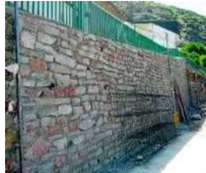
Los trabajos se encuentran en una fase muy avanzada.
