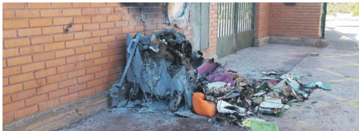
Estado en el que quedó el contenedor tras arder.
