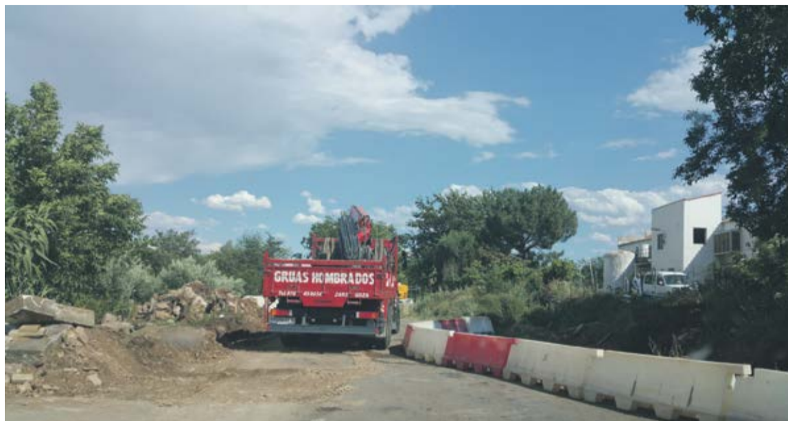
Obras de acondicionamiento en la carretera A-1503.
