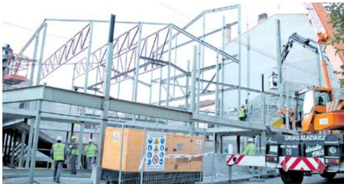
Estado actual de las obras del auditorio.
