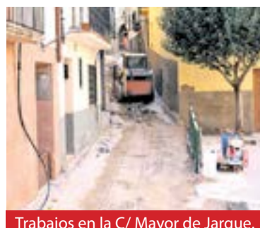
Trabajos en la C/ Mayor de Jarque.
