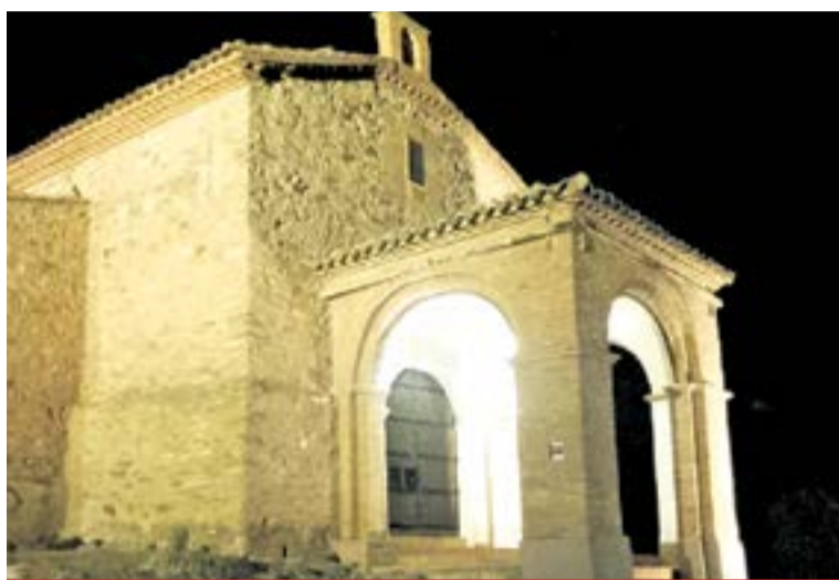
Ermita de San Ildefonso con la nueva iluminación led.
