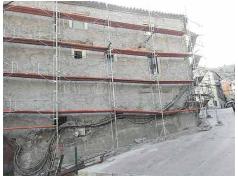
Reparación del edificio municipal.
