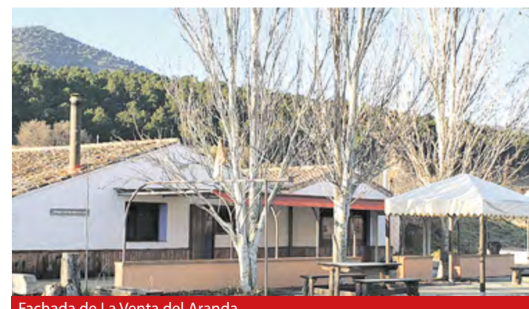
Fachada de La Venta del Aranda.
