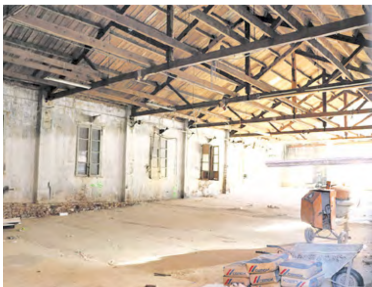
Imagen durante la reforma del edificio.
