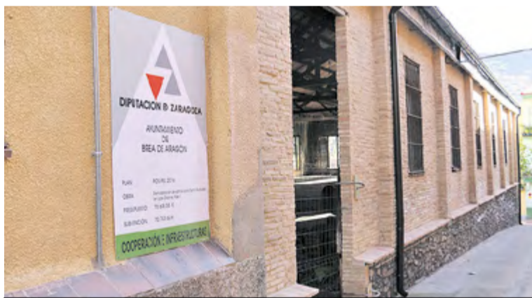
Durante el proceso de reforma.
