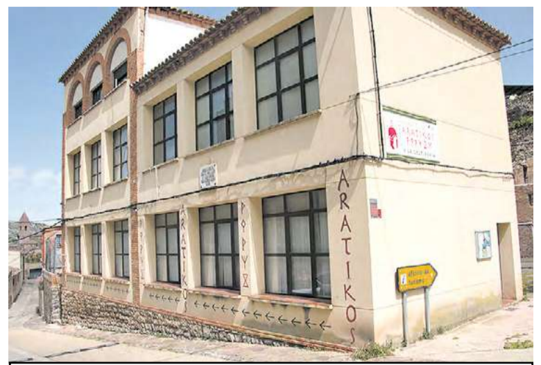
Fachada del edificio Aratikos.
