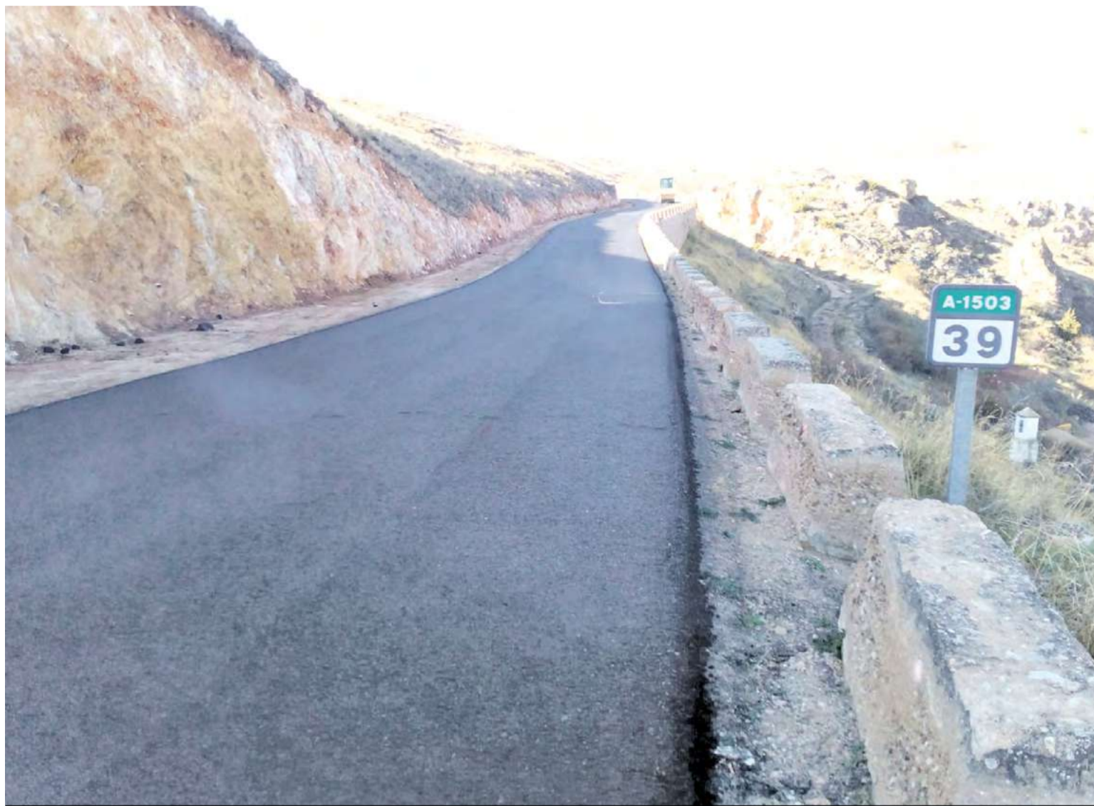
Trabajos de asfaltado.
