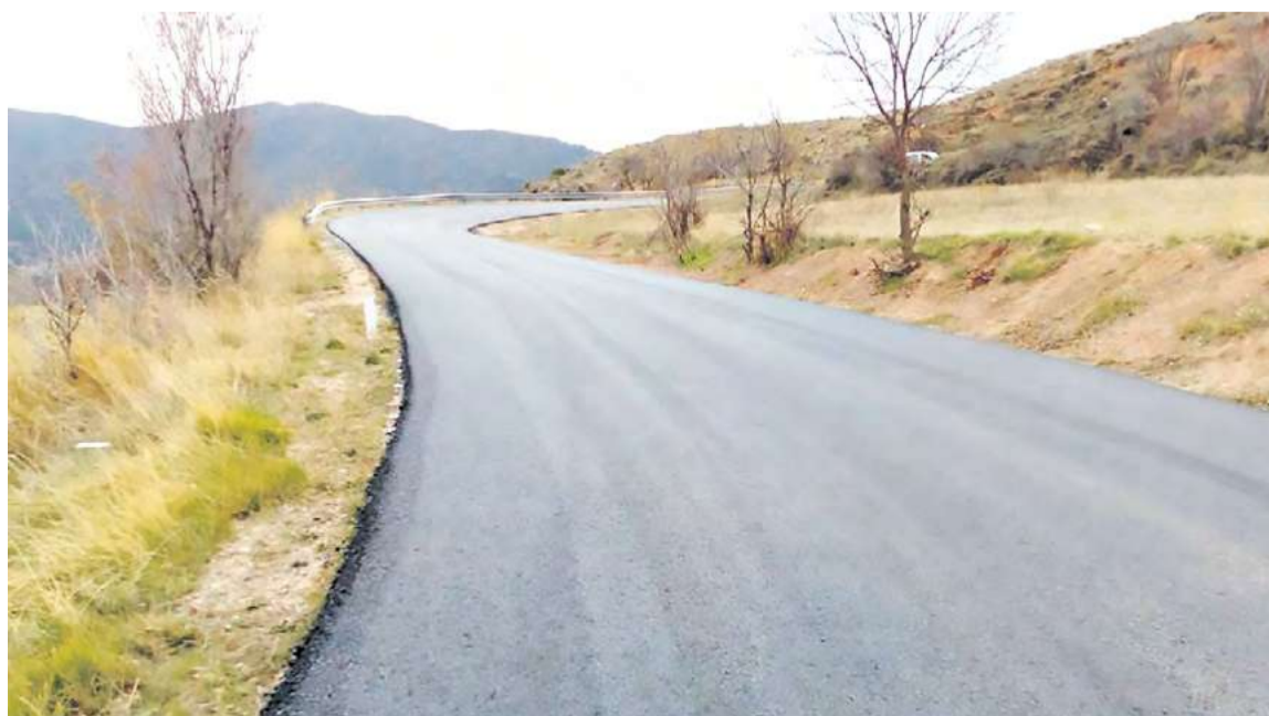
Trabajos de asfaltado.
