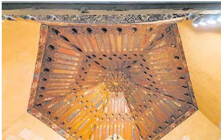
Techumbre de limas moamares de la capilla.
