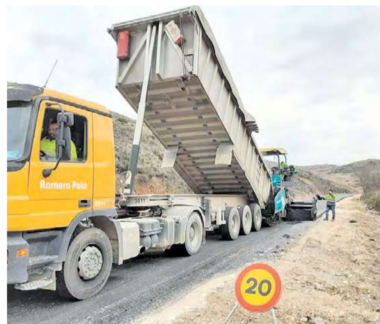
Trabajos de asfaltado.
