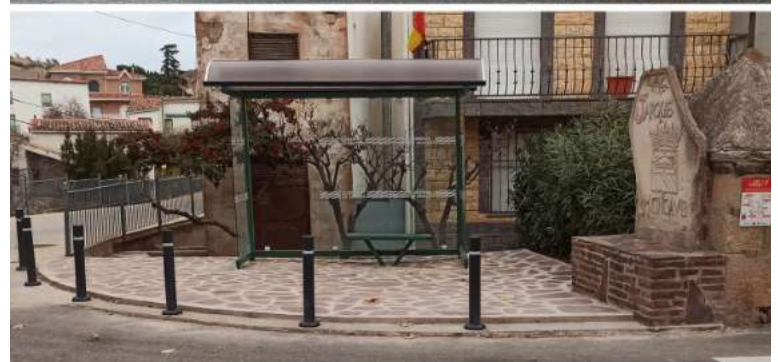
Imagen del antes y después de la reforma.
