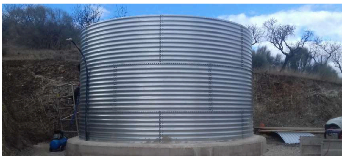
Nuevo deposito de agua.
