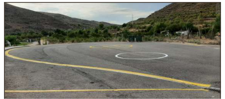
Zona del helipuerto tras los trabajos de pintura.
