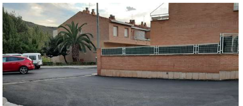
Trabajos de asfaltado
