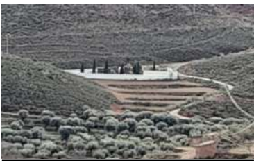
Imagen del muro del cementerio.
