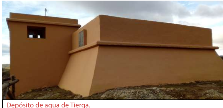
Depósito de agua de Tierga.
