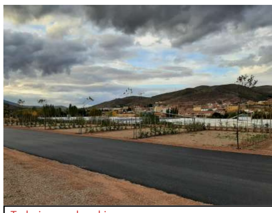
Trabajos en el parking.
