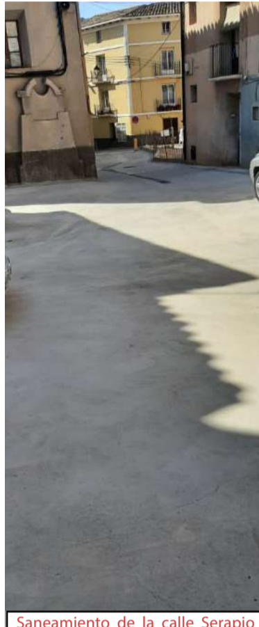
Saneamiento de la calle Serapio Montañés.
