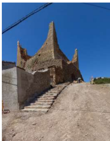
Obras en el castillo de Jarque.
