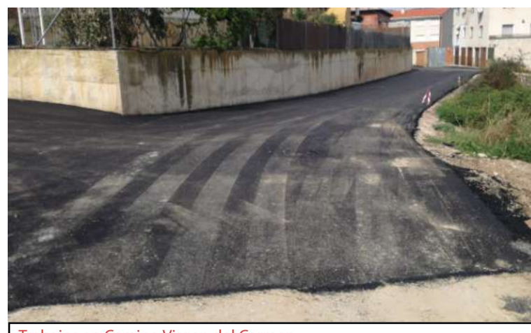
Trabajos en Camino Virgen del Carmen.
