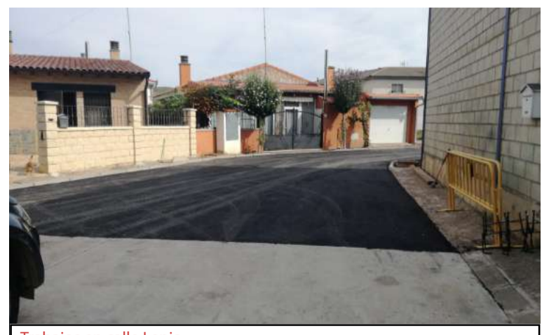
Trabajos en calle Lenje.
