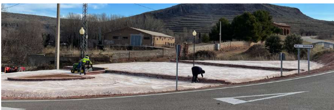
Operarios trabajando en el ajardinamiento.
