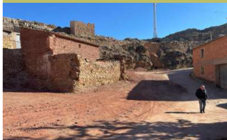
La obra permitirá estacionar a más vehículos.
