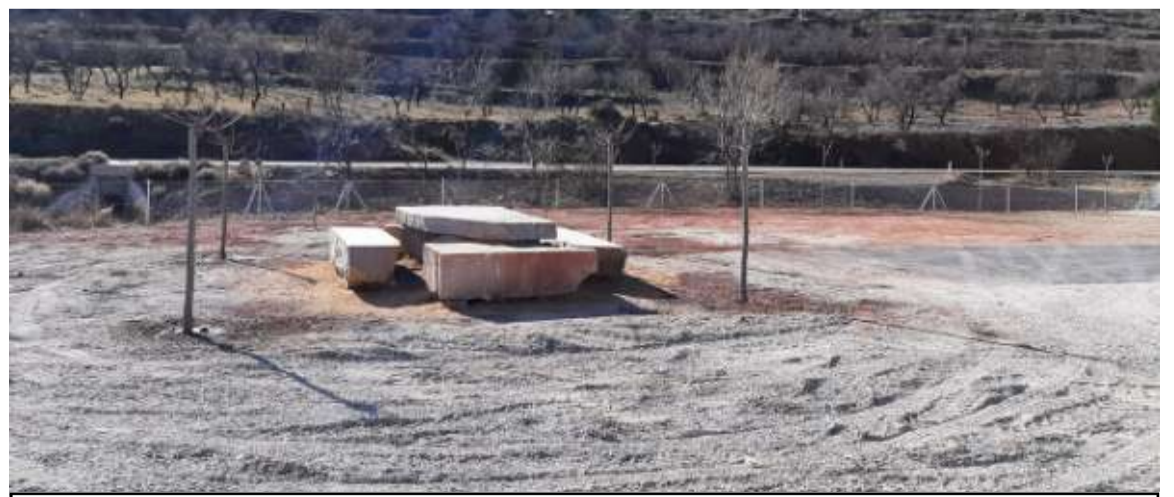
Imagen del estado de las obras del parking de caravanas.
