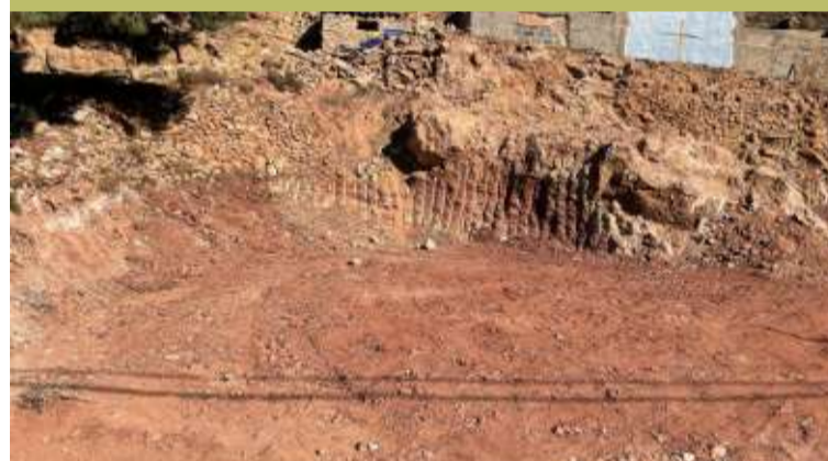
Terreno en el que se ubicará el parking.
