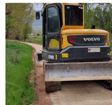
Trabajos de acondicionamiento de la senda fluvial.
