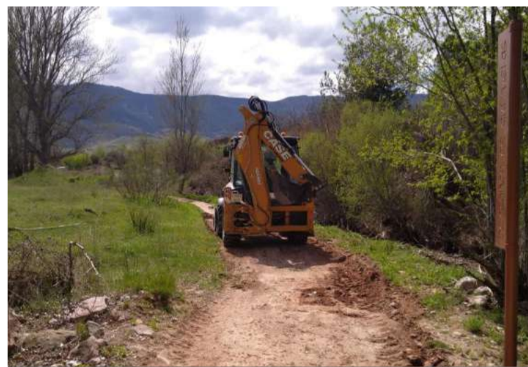
Trabajos de acondicionamiento de la senda fluvial.
