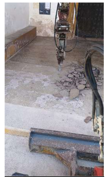
Reparación de las escaleras.
