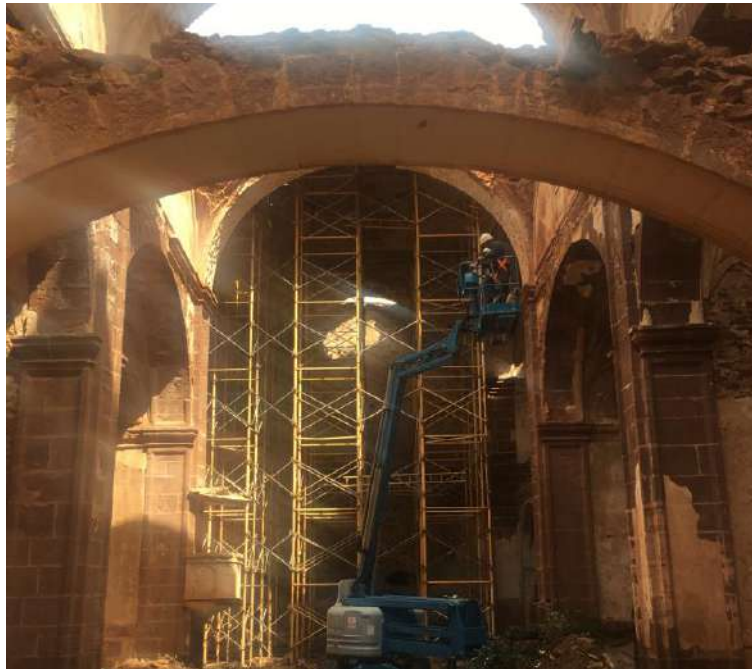
Imagen de la primera fase de las obras.
