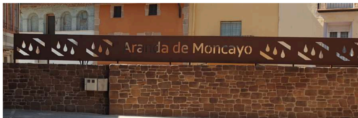
Restauración del muro de la Plaza mayor.
