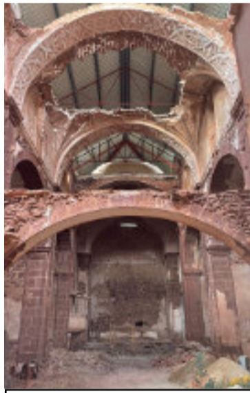
Obras de la iglesia del Convento.
