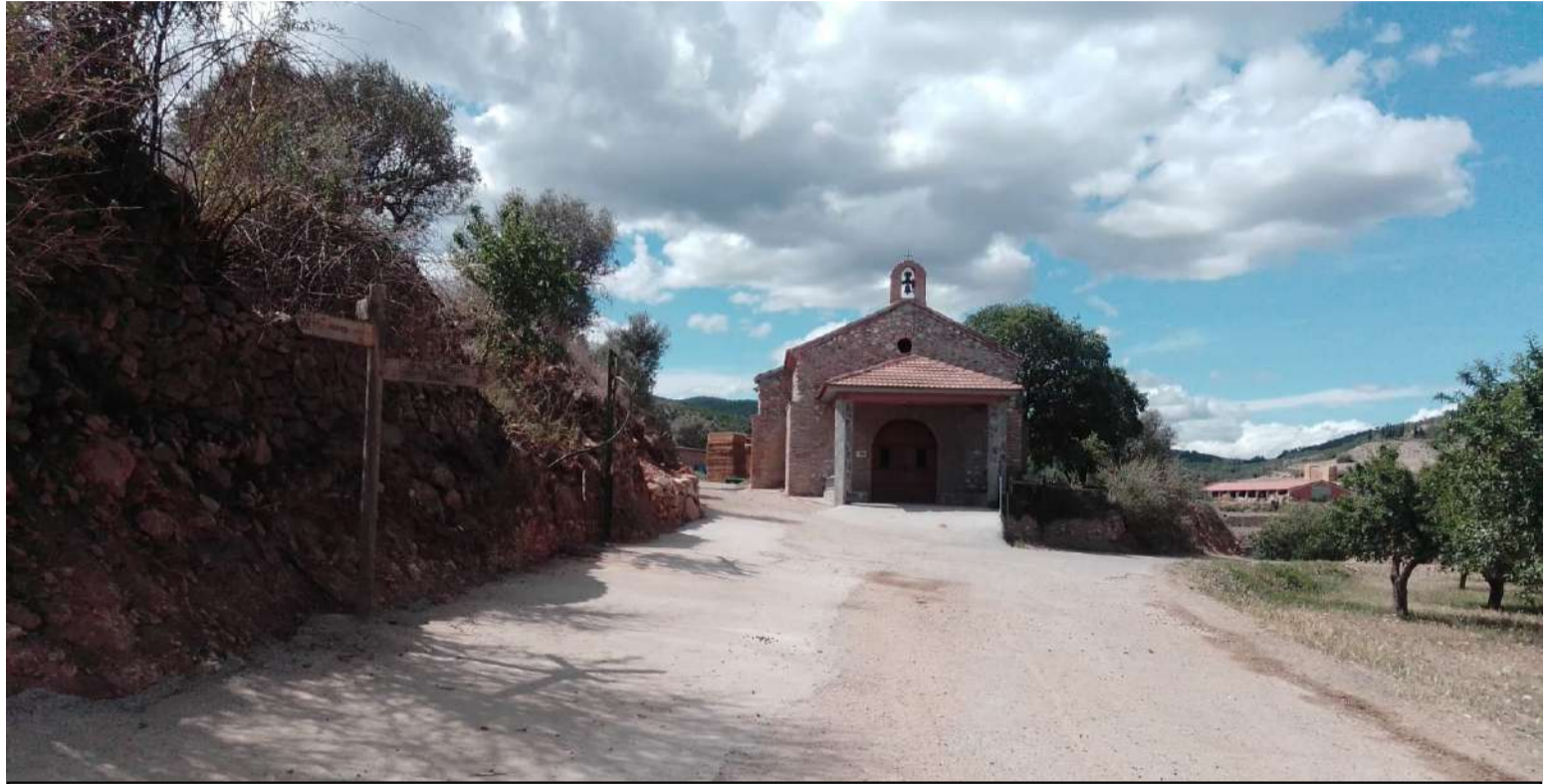
Camino de acceso a la Ermita de San Bartolomé Renovadas.
