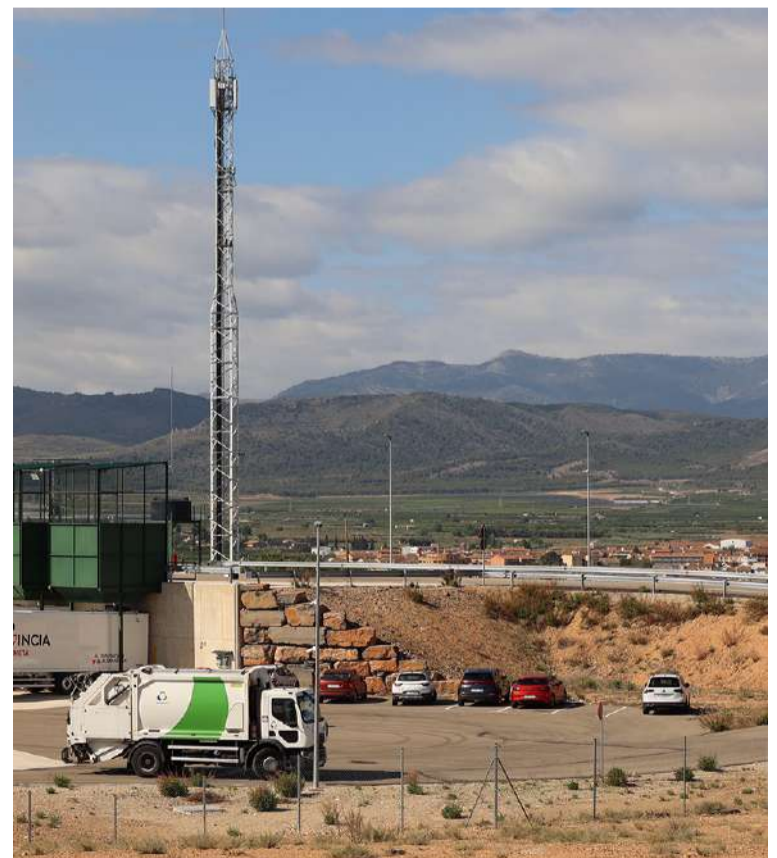
La planta de transferencia de La Almunia se puso en marcha el pasado 10 de mayo y es la que recibe los residuos de la Comarca del Aranda. FOTO: FABIÁN SIMÓN
